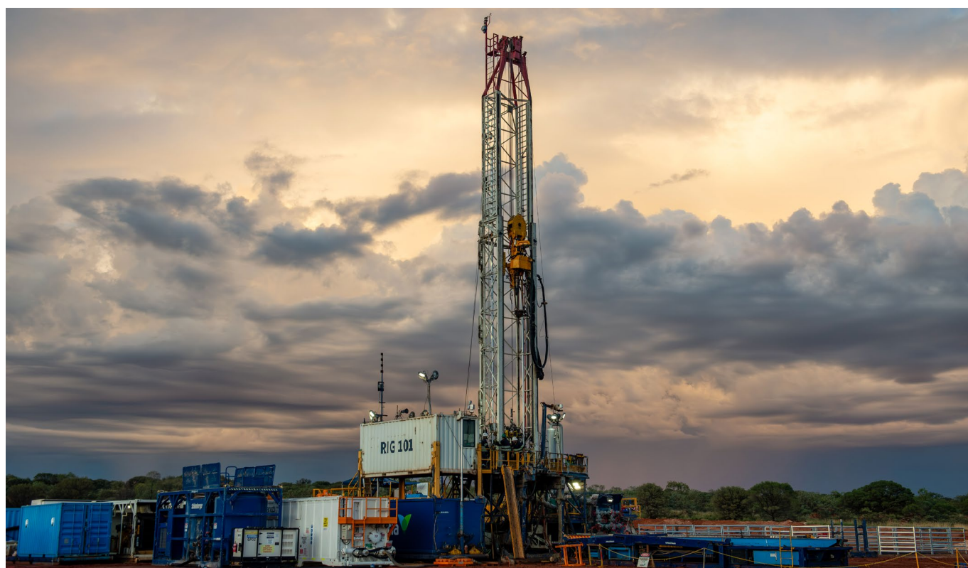
Drilling at Mereenie: WM29
